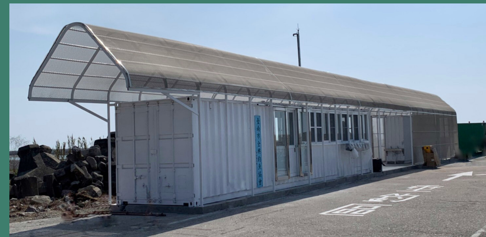
北防波堤垂釣區管理站及廁所
