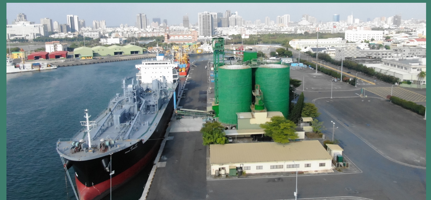
水泥裝卸使用管道式運輸及密閉式倉儲，減少揚塵產生
