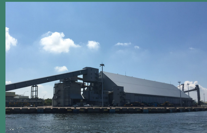
自動化卸煤機及密閉式煤倉
