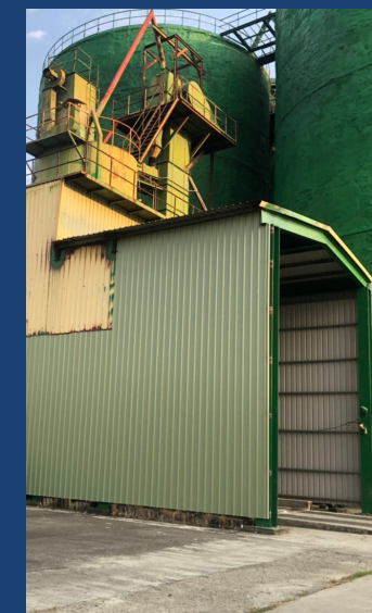
卸料車道圍設鐵皮
