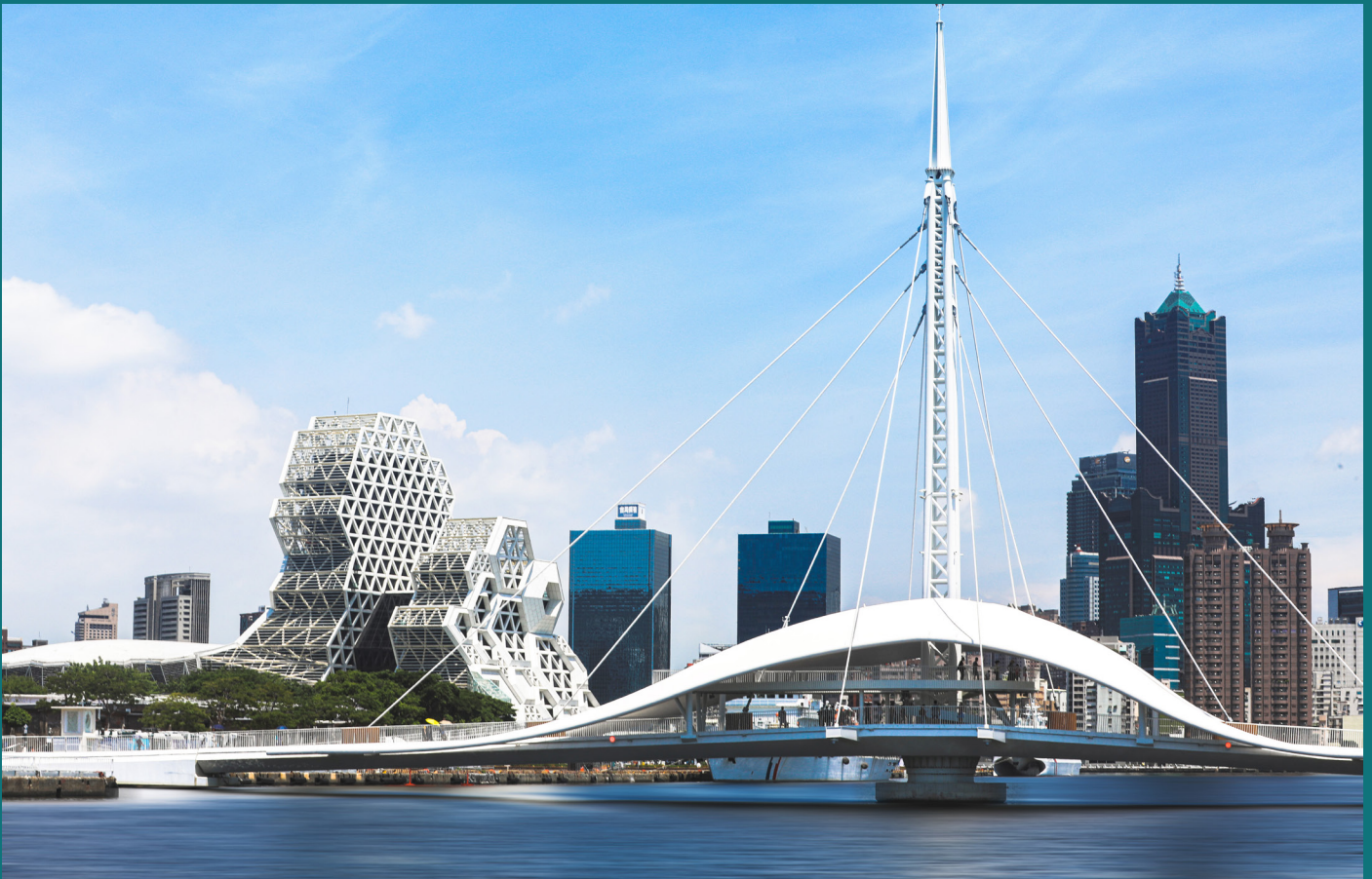
高雄港大港橋座落高雄港第三船渠，為亞洲最長跨港旋轉橋，由港務公司獨立設計與建造，於2020年7月6日正式啟用。大港橋緊臨高雄輕軌駁二大義站，為亞洲新灣區北端重要水岸拼圖，結合高雄水岸輕軌，串連駁二藝術特區、高港棧庫群，形塑高雄港水岸觀光廊道。
