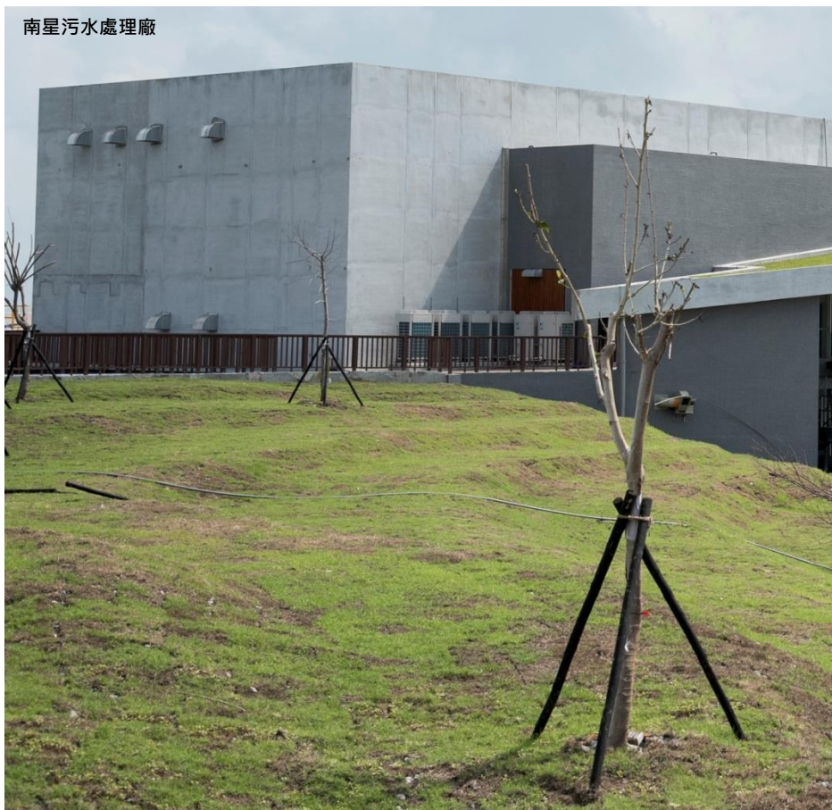
污水處理設備
